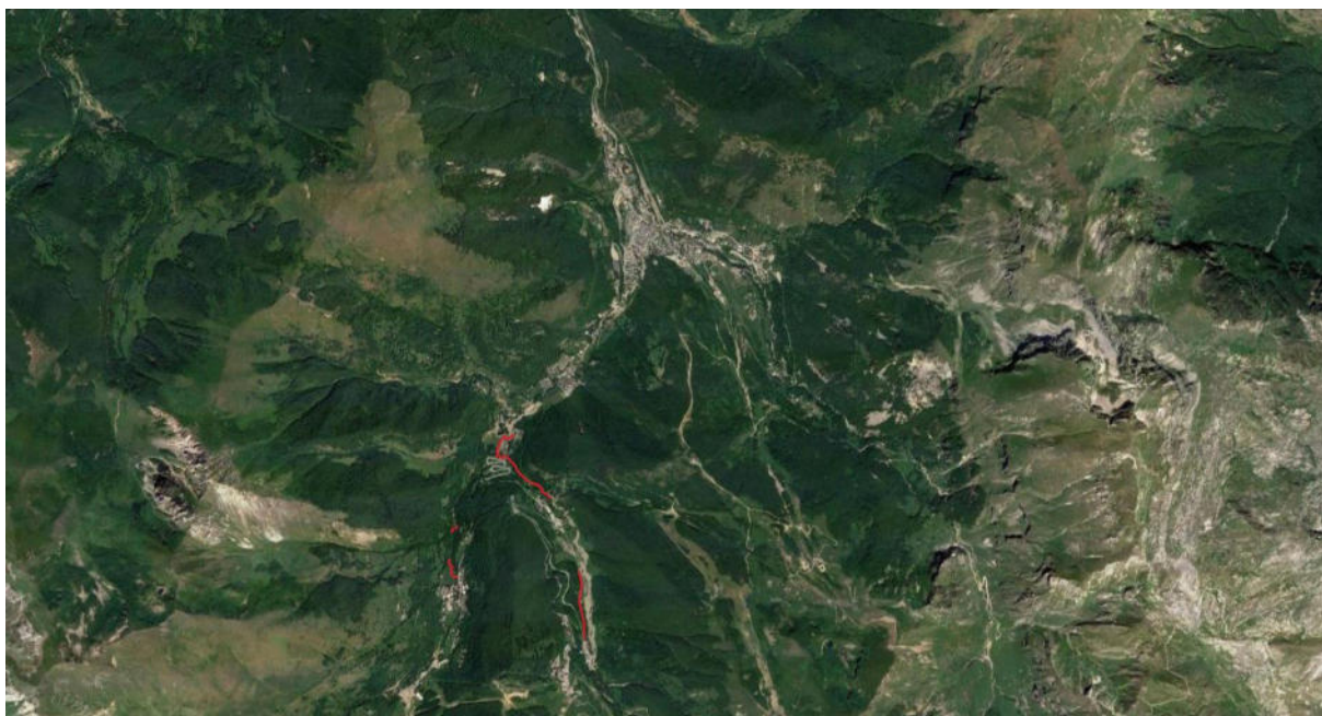
Figura 1 – Vista aerea condotta in progetto (tracciato in rosso) in comune di Limone Piemonte (Fonte:ortofoto google)
